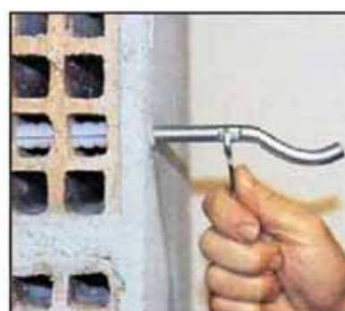
Regolare la distanza dalla parete ruotando la mensola con la chiave utilizzando
