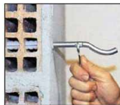
Regolare la distanza dalla parete ruotando la mensola con la chiave utilizzando
